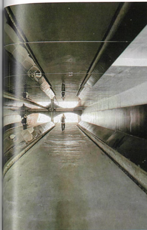
地下道採用鏡面不鏽鋼，營造寬敞空間。
